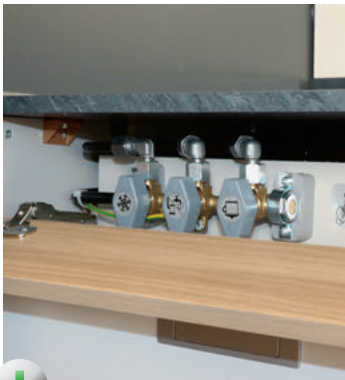
+ Perfekt erreichbare Absperrhähne.
