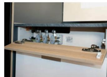
Robinetts de verrouillage derrière l'habillage de gauche.
